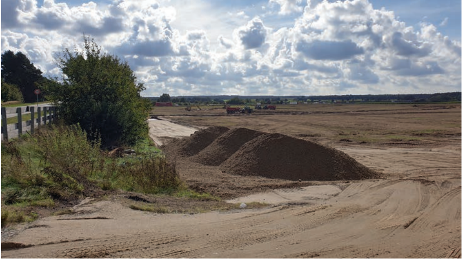
Baubeginn am Autohof Evendorf
