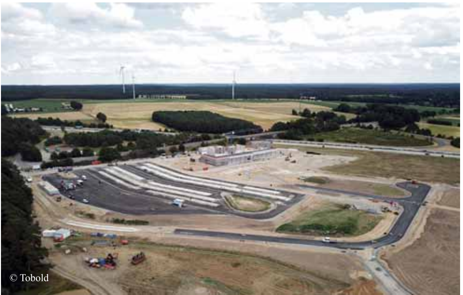
Die Autohofbaustelle am 04.07.2022, links hinten kann man auch das erste neue große Windrad von RWE sehen.
